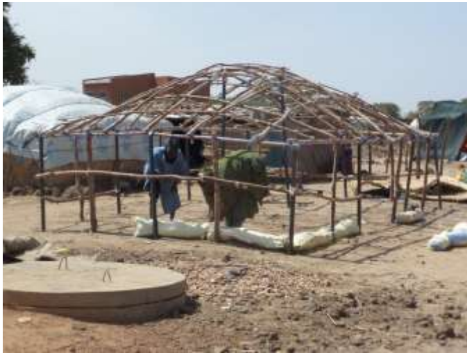
Vue d'un abri en cours d'autoconstruction
